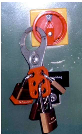
Abb. 3-4 Bügelschloss im Einsatz
