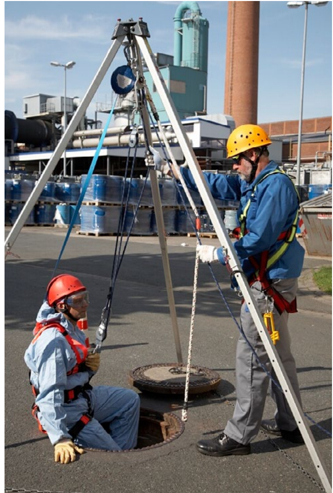
Abb. 9-4 Einstieg in einen Kanal mit erforderlicher Schutzausrüstung
